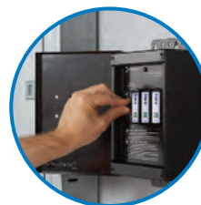
Paso 2. Inserte el nuevo módulo
